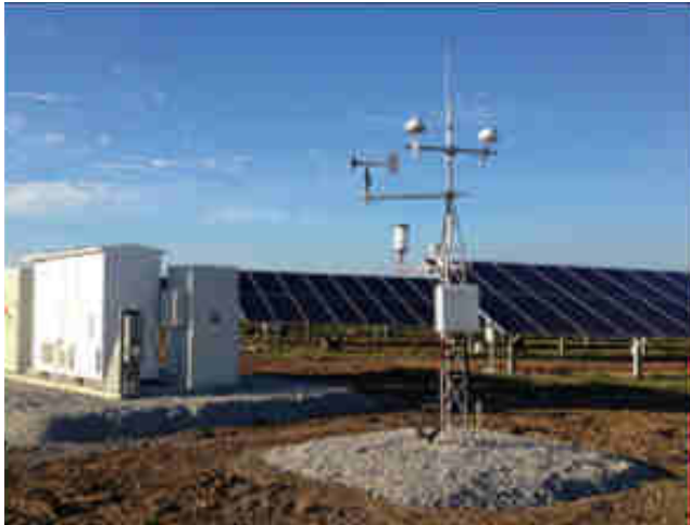
Esempio di stazione meteo
